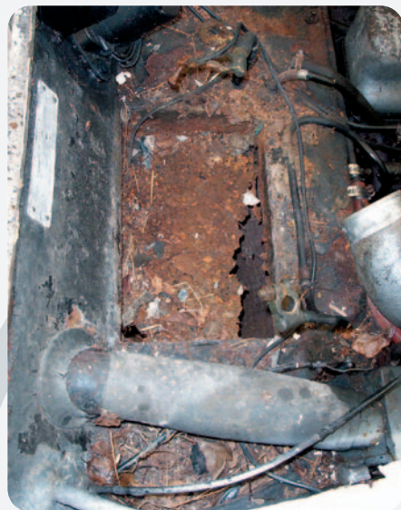
Corrosión habitual en el hueco de la batería.
